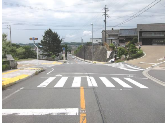
■一般県道亀山停車場石水溪線
