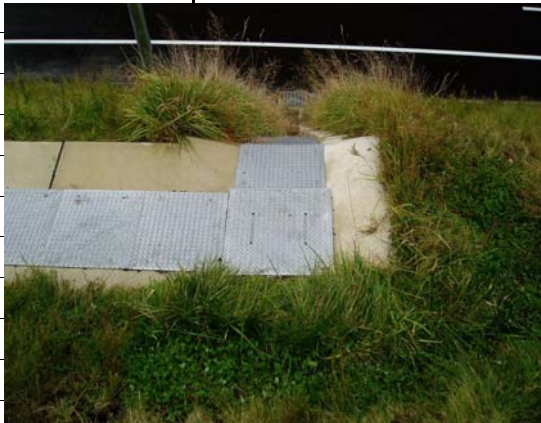
縦排水溝の飛跳ね防止対策の施工例
