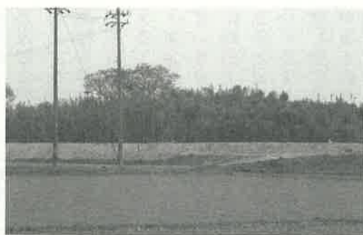
鈴鹿川堤防かさ上げ工事
