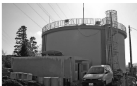
工業用水道配水池
