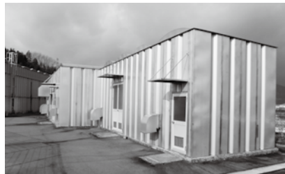
新神辺配水池
