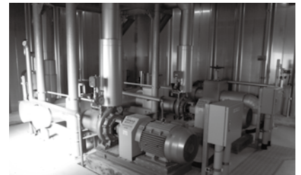
送水ポンプ設備
