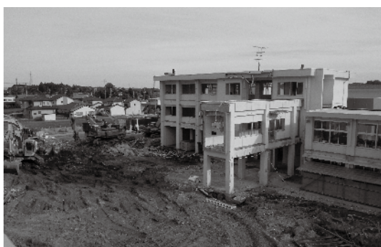
川崎小学校校舎改築工事に係る建築工事現場
