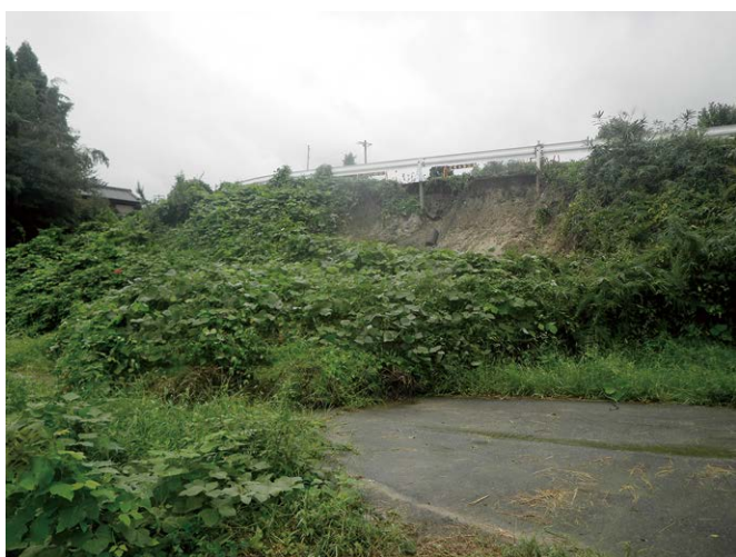
道路の被害（市道阿野田30号線）
