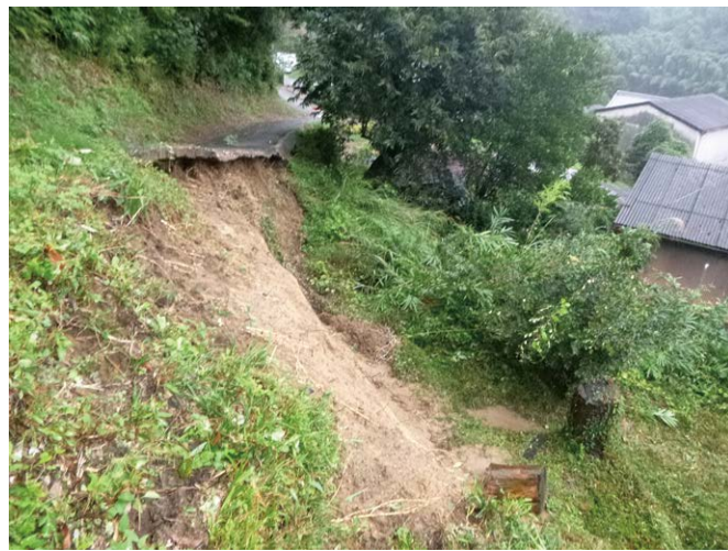
農道の被害（小川町）
