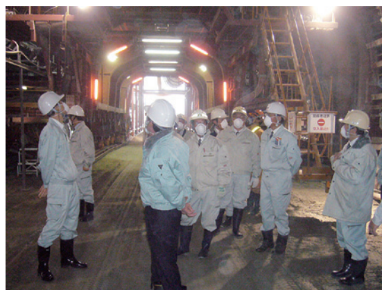
新名神高速道路（野登トンネル）
