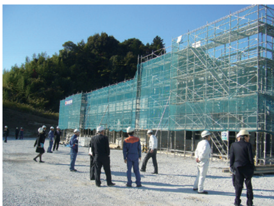
消防北東分署建設現場
