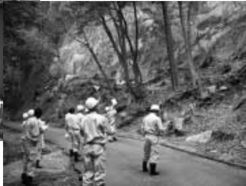
安楽越線落石防護工事、予防治山事業第2号工事現場
